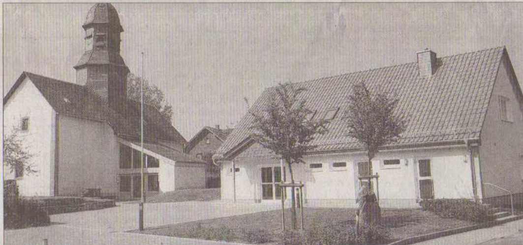
In neuem Glanz: das fertig sanierte evangelische Gemeindehaus Queckborn.
